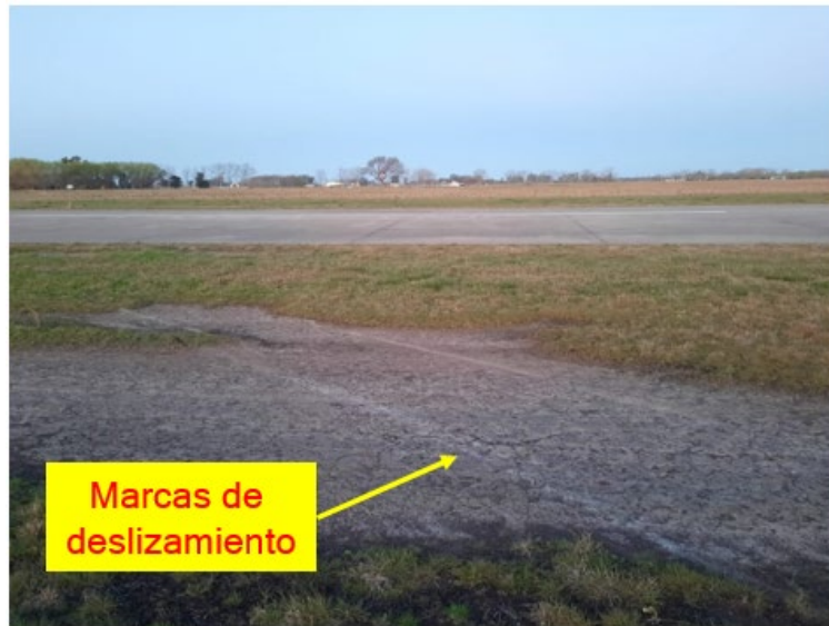
Figura 8. Marcas de salida de pista. Fuente: investigación JST
