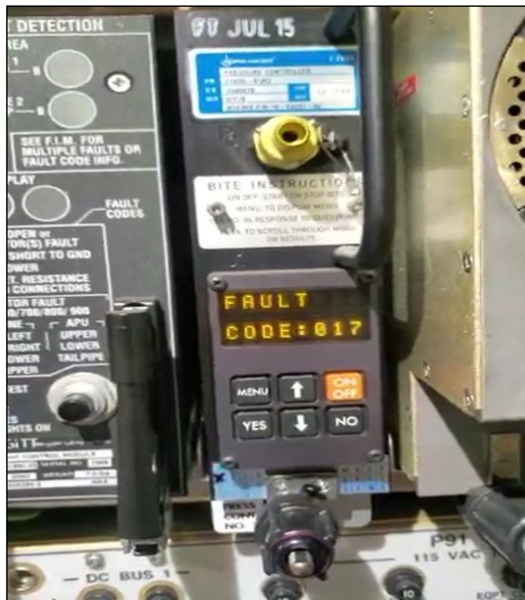
Figura 13. Panel de descarga de datos de los CPC. Fuente: investigación JST
